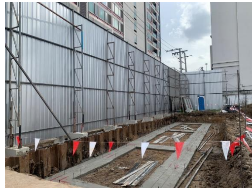
รูปที่ 5 การติดตั้ง Sheet Pile (เมื่อช่วงเดือนพฤษภาคม พ.ศ.2565)
