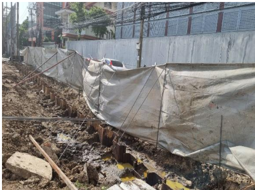
รูปที่ 5 การติดตั้ง Sheet Pile (เมื่อช่วงเดือนพฤษภาคม พ.ศ.2565)
