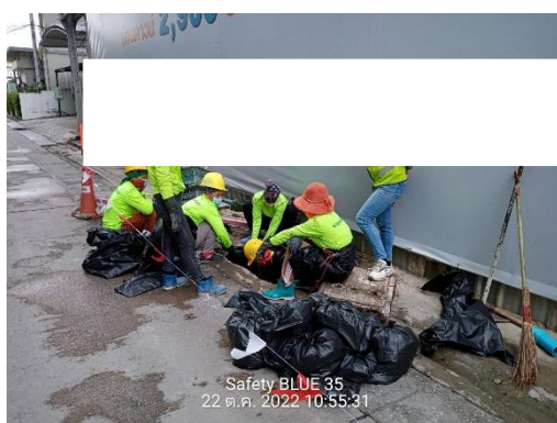
รูปที่ 46 ลอกท่อระบายน้ำ
