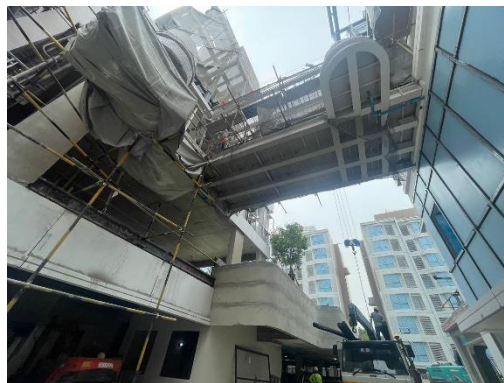
รูปที่ 25 ติดตั้งผ้าใบกันฝุ่น (Mesh Sheet)
