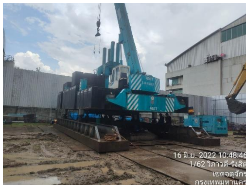
รูปที่ 33 การเจาะเสาเข็มแบบ Jack in Pile
